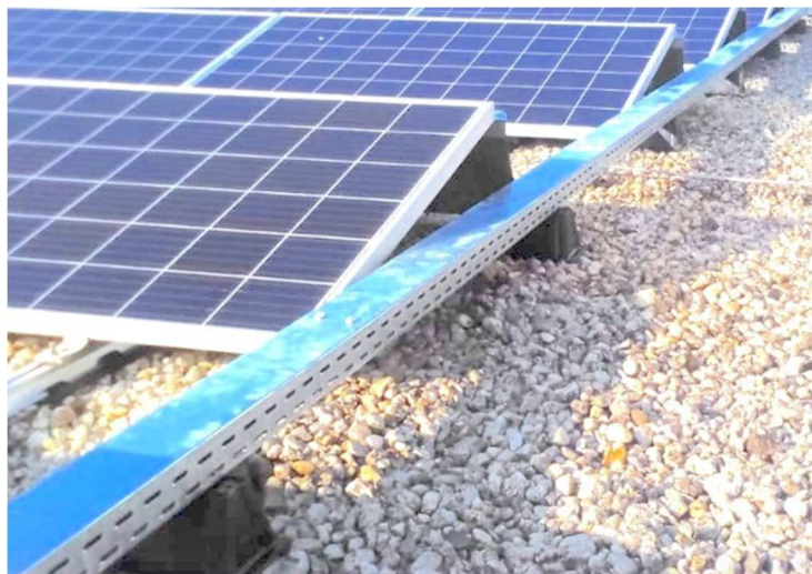
Rys. Przykład wykonanej trasy kablowej DC
